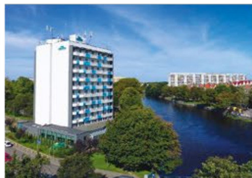
Außenansicht 3+ Aparthotel Nad Parseta
