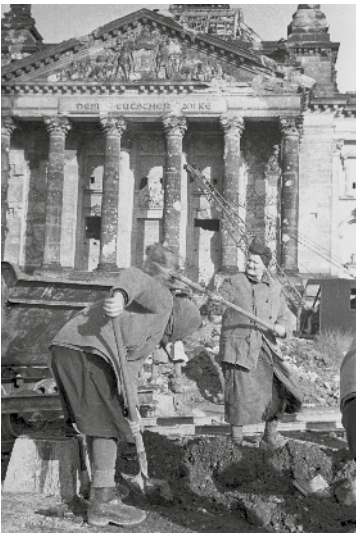
Foto: zbarchiv / picture alliance Auf dem Platz der Republik vor dem stark beschädigten Reichstagsgebäude waren 1948 diese „Trümmerfrauen“ im Einsatz.
