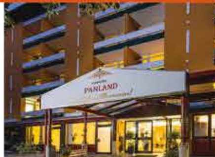
3+ Kurhotel Panland, Außenansicht
